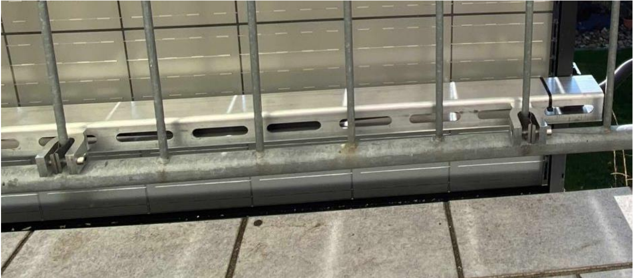
Abb. 10/ Montageschiene an Spezialklemme
