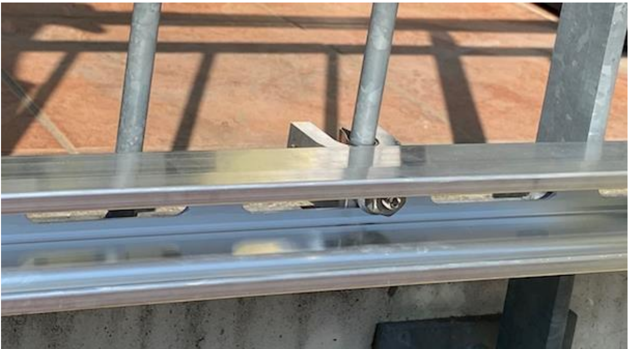
Abb.g 11/Montageschiene und Spezialklemme von außen
