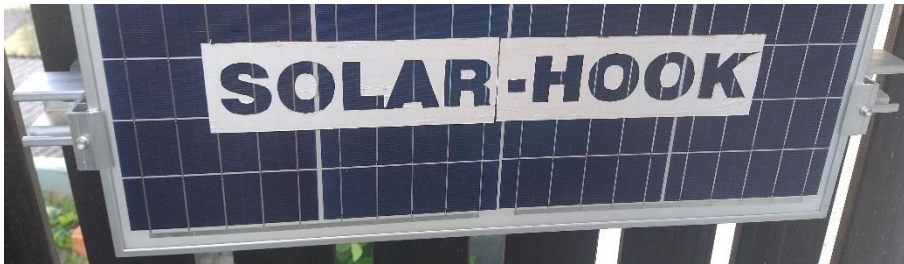
Abb. 12/Modulendklemme anbringen rechts und links
