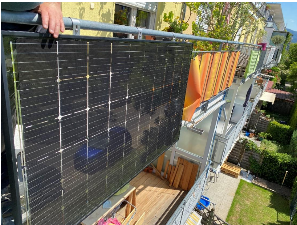
Abb. 18/Ansicht von außen
