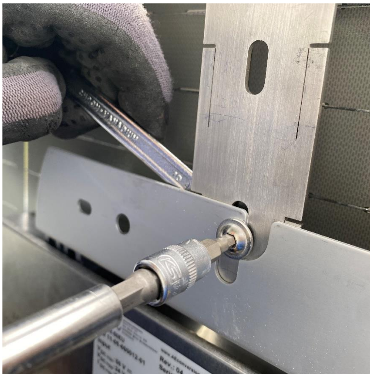
Abb. 6/Wechselrichter am SOLAR-HOOK Befestigungsbügel anschrauben
